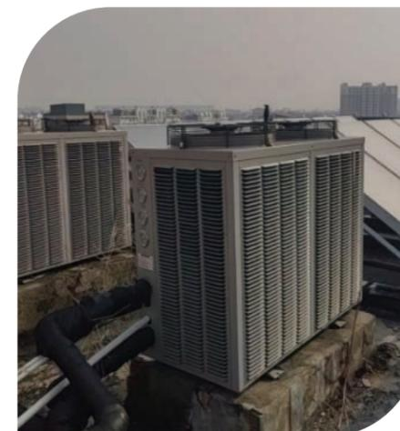
宿舍熱水器由電熱水器更換成太陽能及電熱水機組
